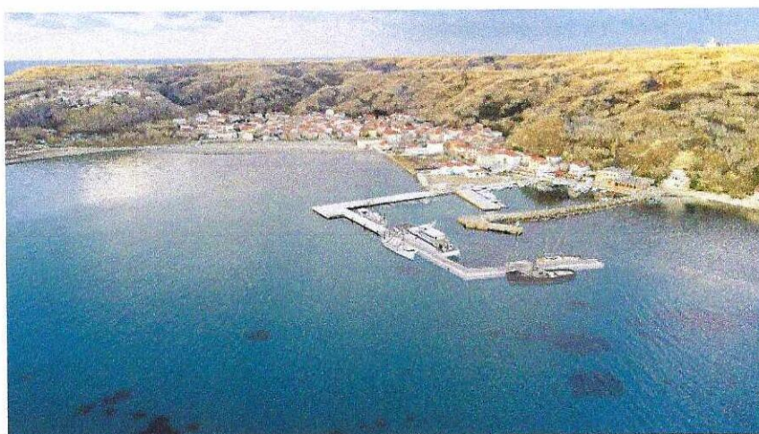
Dogradnja luke Susak
